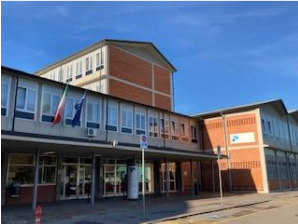
La facciata principale dell'edificio scolastico
